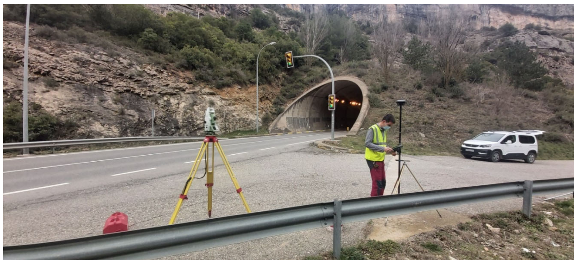
Boca sud túnel de Terradets /C-13 de Lleida a Tremp
