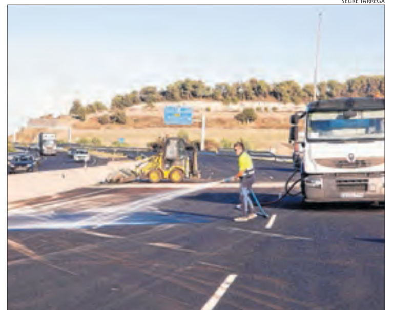
Treballs ahir a la tarda per reobrir la carretera.
