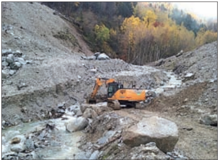
FOTO: CHE / Una excavadora treballant a la llera del riu
