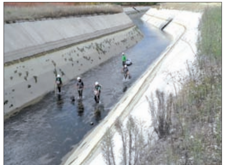
FOTO: ACN/ Diversos tècnics fent les tasques de manteniment del canal
