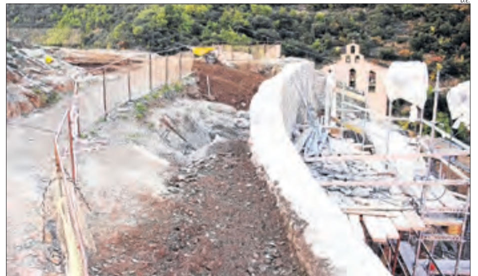
Inversió de 48.220 euros al castell de Castellbò. En l'actualitat, s'executa el nou mur que segueix el traçat de la muralla del segle VIII i que s'ha ancorat a la pedra.
