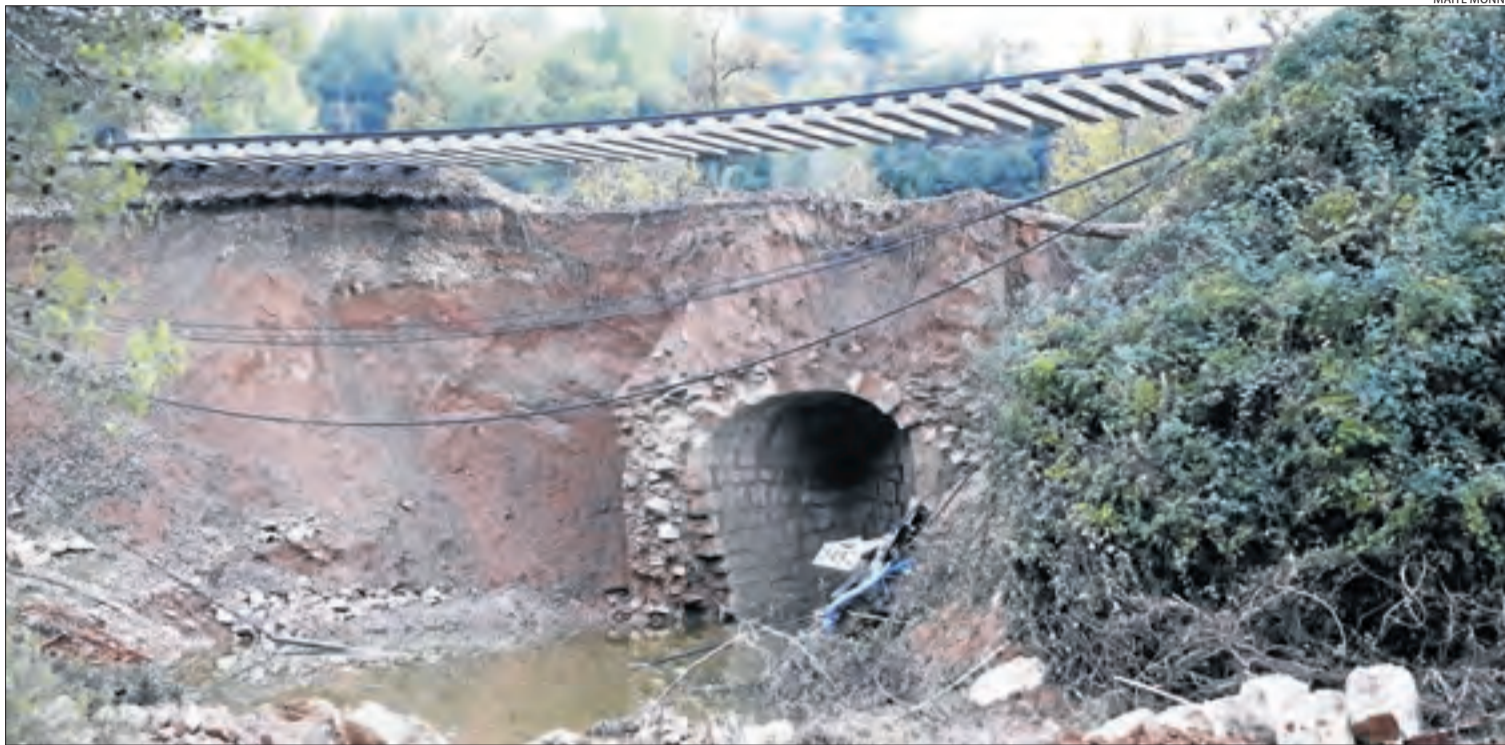
Imatge d'arxiu del tram de la via del tren de la costa que va quedar penjant a Vinaixa després de les inundacions del 22 d'octubre.
