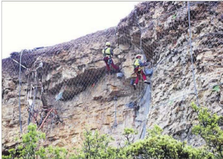
Obres en talussos de la carretera LV-9124 a la zona de Castell de Mur, amb alt risc geològic.
