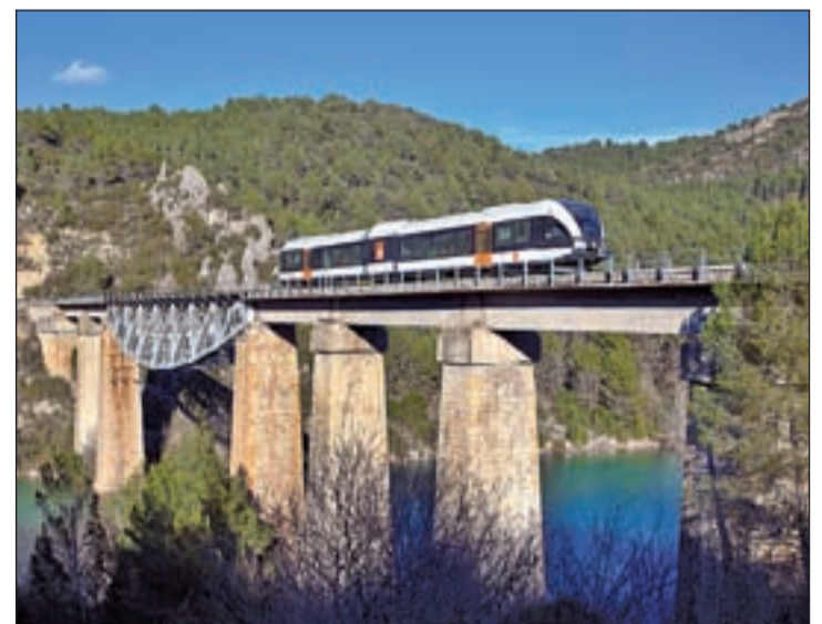
FOTO: Ferrocarrils / Imatge d'arxiu del tren de la línia Lleida-la Pobla
