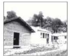
L'edifici al segle XX.
