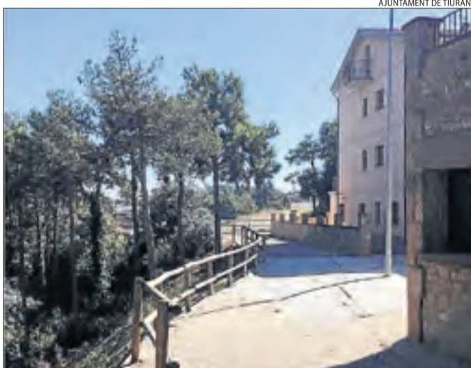
Actual mur d'escullera que es tornarà a construir.
