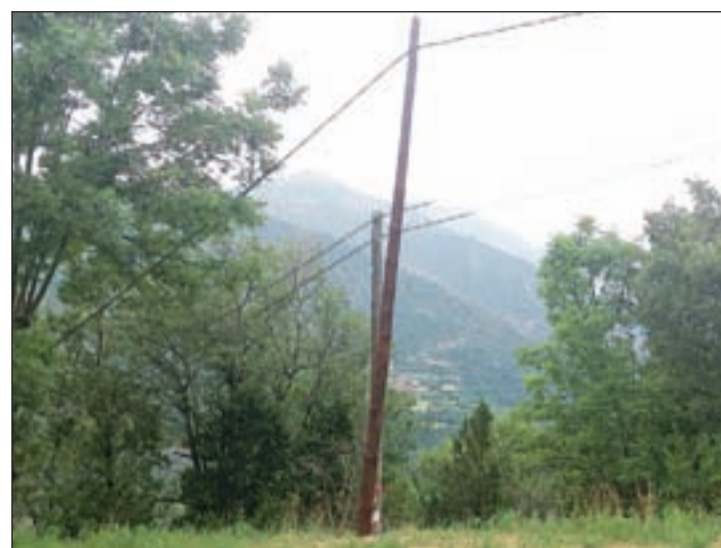
FOTO: Endesa / Imatge d'una tram de la línia que s'ha reformat
