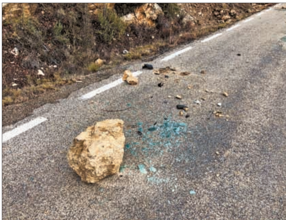
FOTO: Abraham Orriols (Tv3) / Les pedres de l'esllavissada van impactar contra la finestra d'un cotxe a la via
