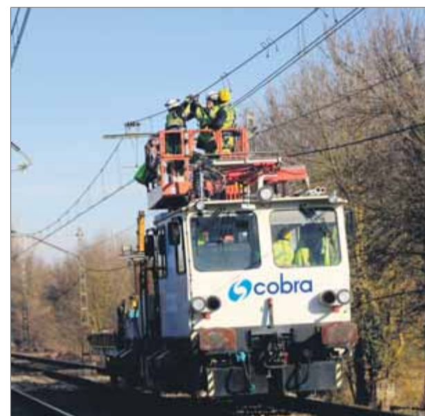
Operaris reparant la catenària entre Caldes de Malavella i Riudellots de la Selva que va quedar afectada pel foc ■ ACN
