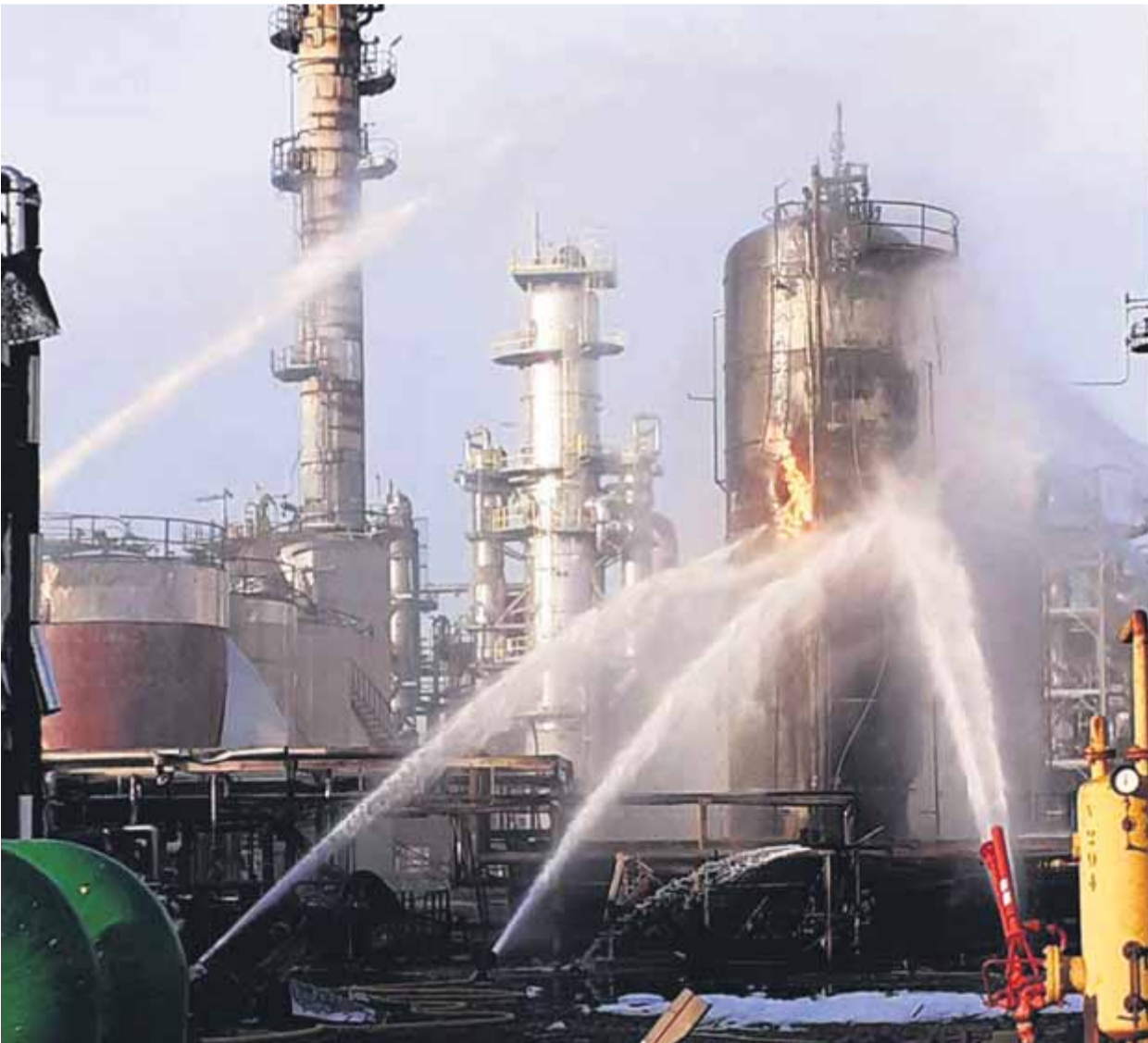
Uns monitors d'aigua dels bombers refreden un tanc d'òxid de propilè ahir a les instal·lacions d'Iqoxe ■ @BOMBERS
