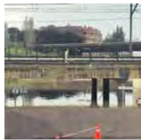
Un pas inundat sota les vies de Castelldefels ■ R.M.B.
