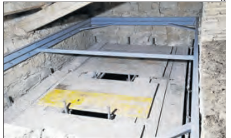
Detalls de les bigues amb que s'ha reforçat l'estructura.
