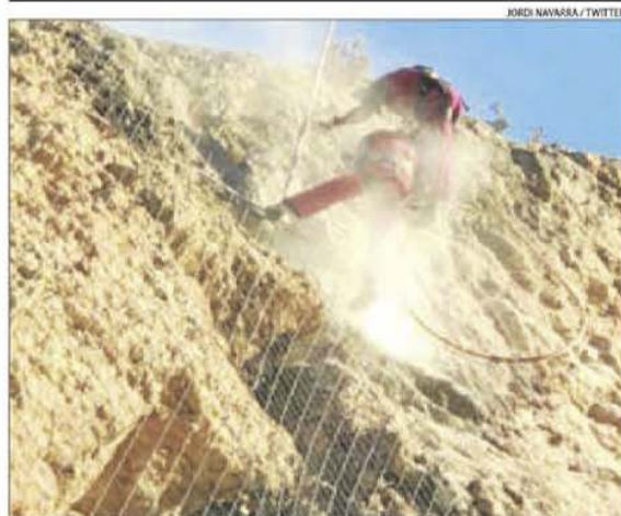
Imatge de les obres per col·locar les malles de protecció.
