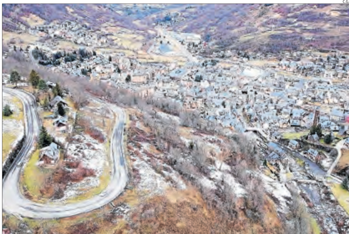
Vista panoràmica de la carretera N-230 al seu pas per Vielha.
