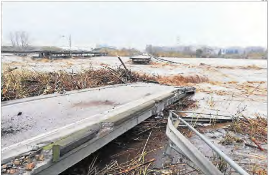
Imatge del pont que va cedir per la força de l'aigua entre les localitats de Blanes i Malgrat de Mar per l'avinguda del riu Tordera.
