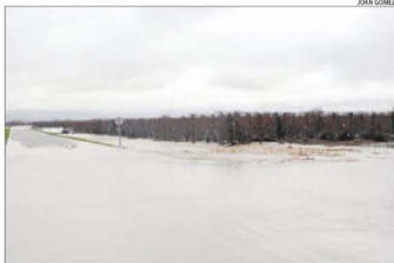
La via entre Barbens i Tornabous va quedar totalment negada.
