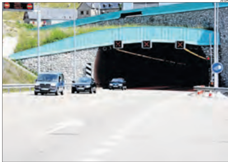
Imatge d'arxiu del túnel de Vielha, on s'actuarà.
