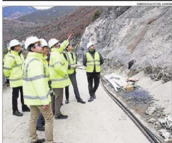
Tècnics del Mitma, ahir a les obres de l'N-260.
