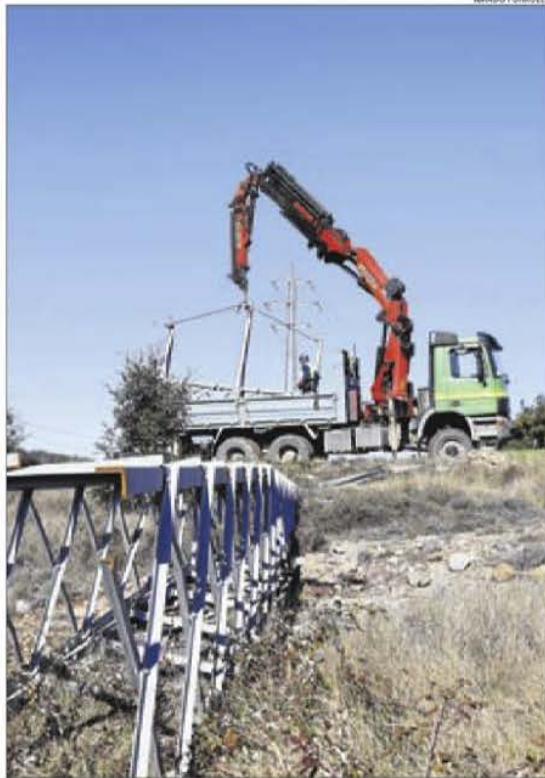
Operaris desmuntant la línia centenària al port de Comiols.
