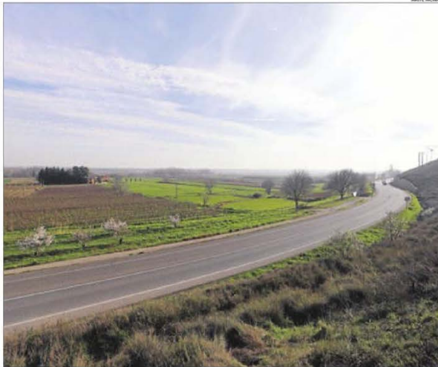
La zona on es planteja la macrocentral solar, en terrenys de Balaguer i de Tèrmens.
