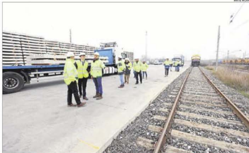
Al camió, les noves travesses de formigó que substituiran les de fusta que ara hi ha a la via.
