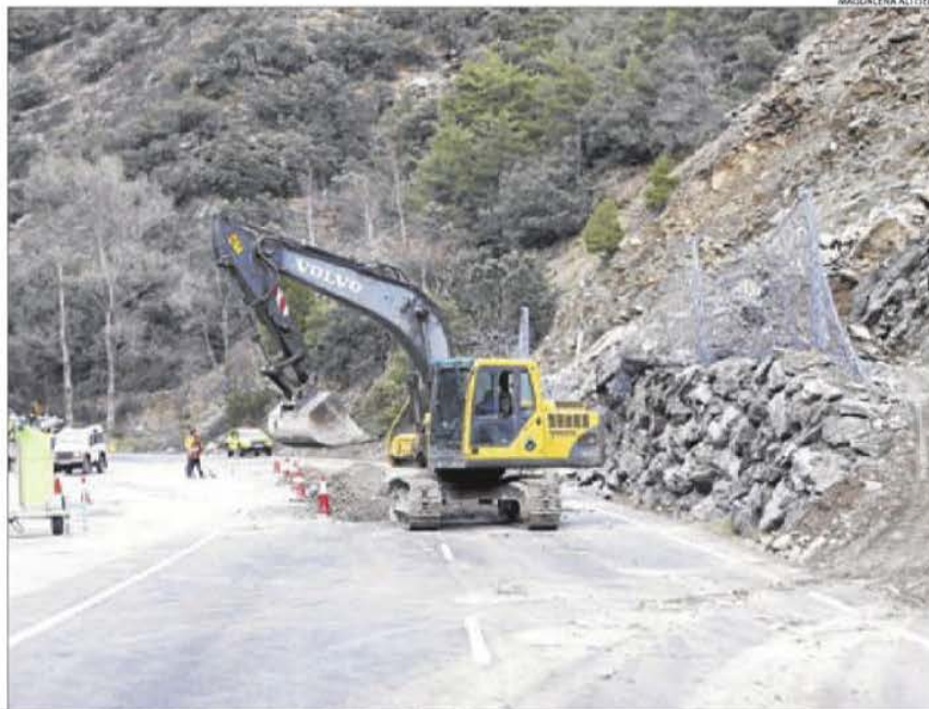
Primers treballs per estabilitzar el talús de la C-13 a Llavorsí el mes d'octubre passat.
