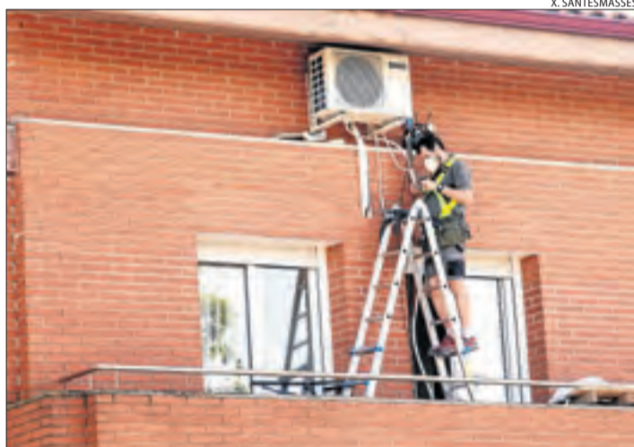
Treballs en una instal·lació d'aire condicionat a Guissona.
