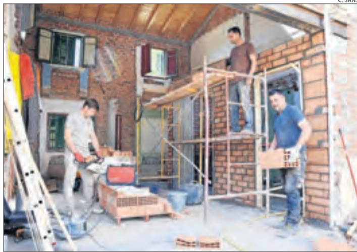
Obres en un edifici de la Seu d'Urgell.
