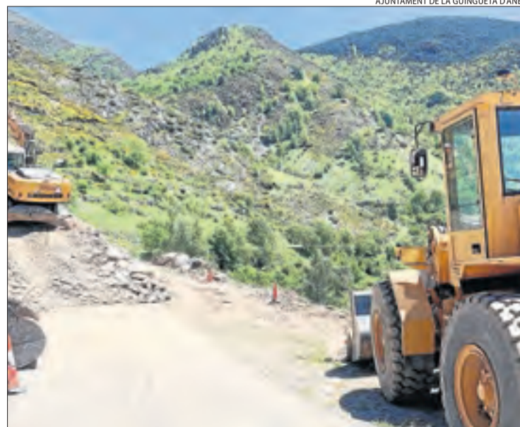
Treballs de neteja a la via on va haver-hi un despreniment.
