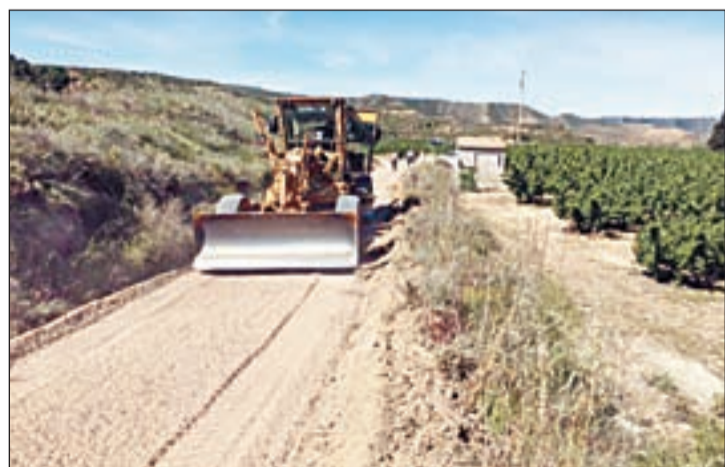
FOTO: Aj. Granja / Màquina utilitzada en el manteniment de camins
