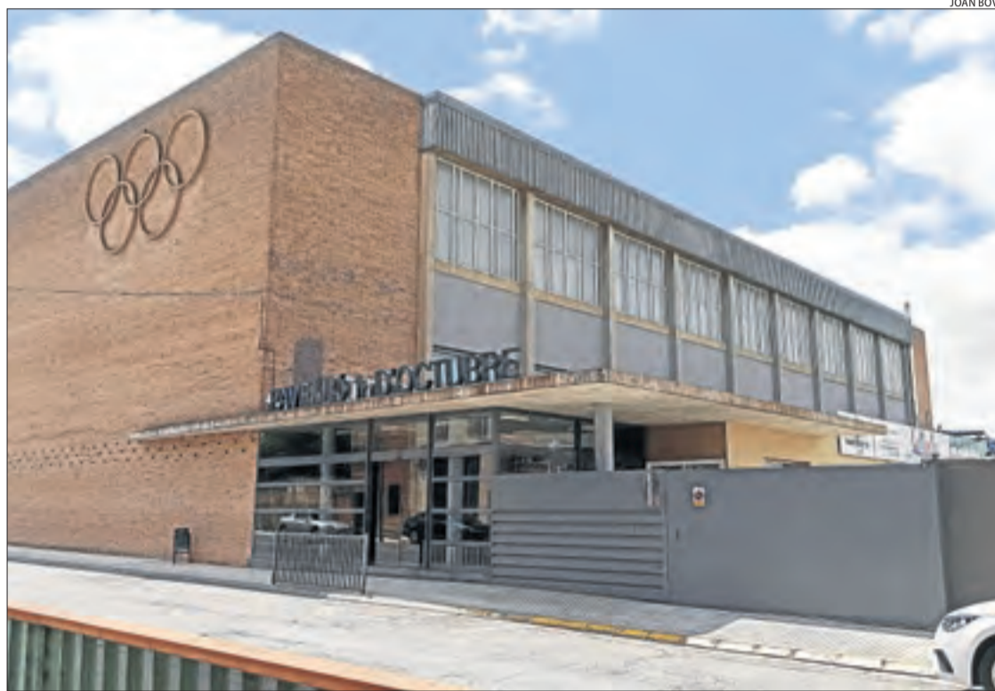
Vista exterior del pavelló Primer d'Octubre de Balaguer.
