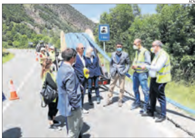
Fibra òptica al Sobirà ■ Les obres per desplegar la fibra òptica de la Generalitat al Sobirà permetran connectar el 90% de la població de la comarca davant del 14% actual.
