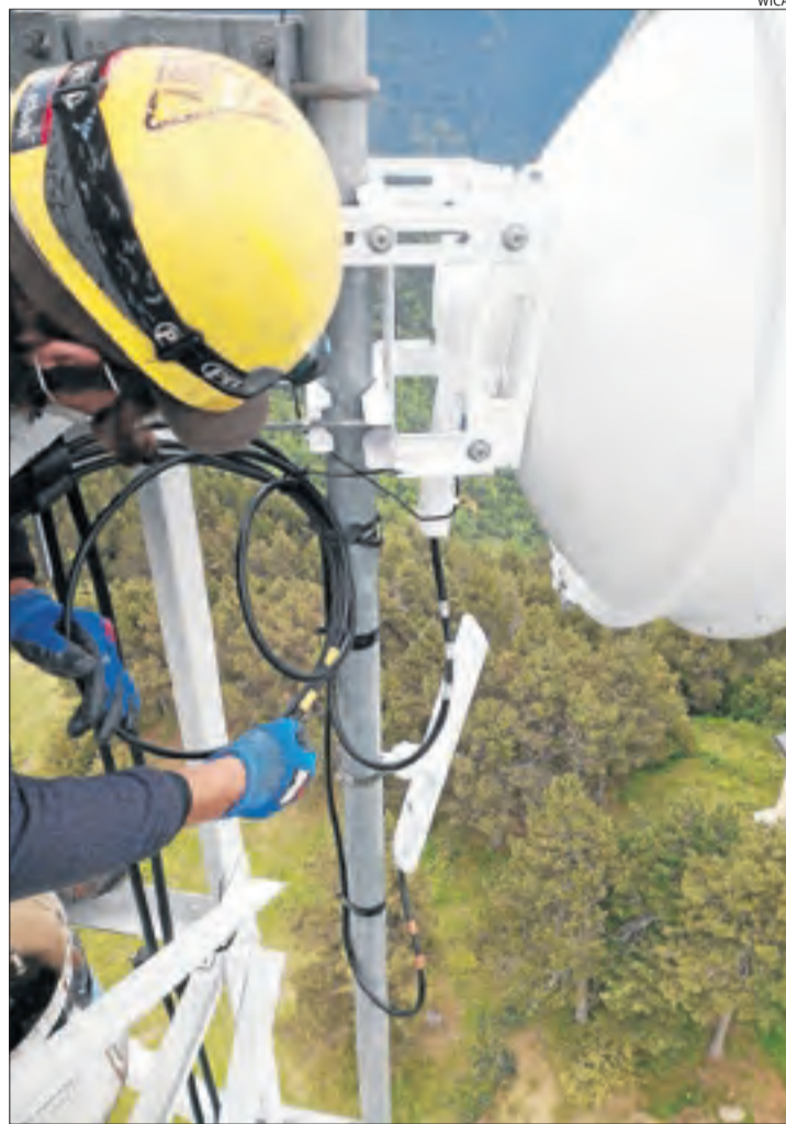
Instal·lació d'una antena d'Internet a la Vall de Boí.
