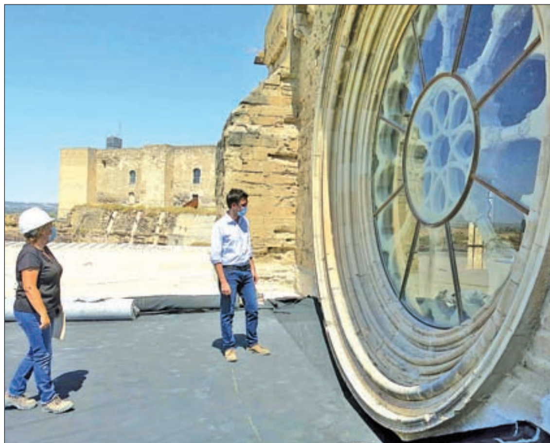
FOTO: Paeria / El alcalde accidental, Toni Postius, visitó ayer las obras de restauración de la Seu Vella
