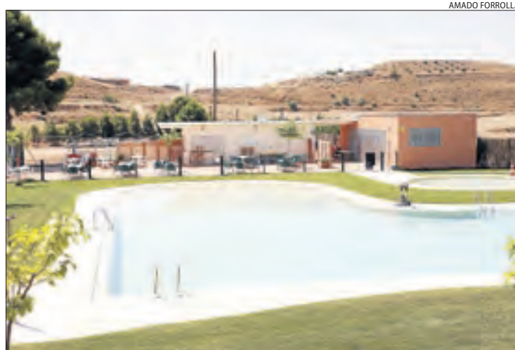
Les piscines d'Alfés, tancades, tornaran a obrir avui.
