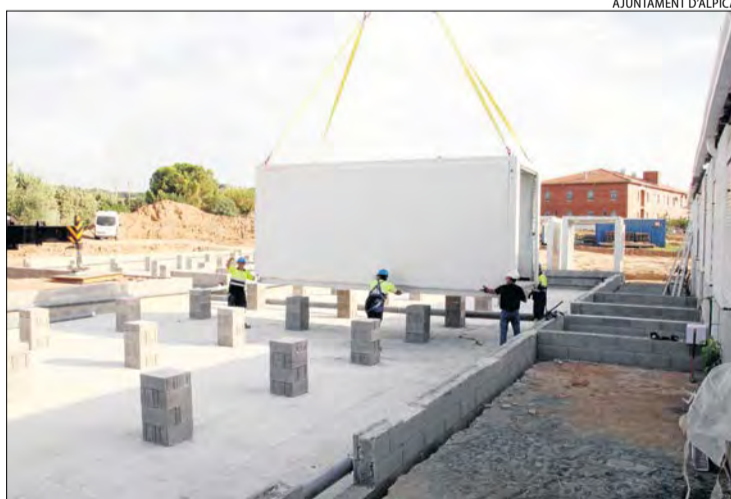
Imatge de la instal·lació dels mòduls de l'institut d'Alpicat.
