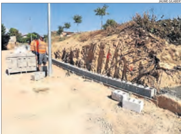
Imatge de les obres per construir el mur de contenció.
