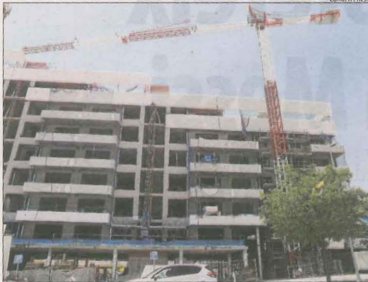
Imatge d'un edifici en construcció.
