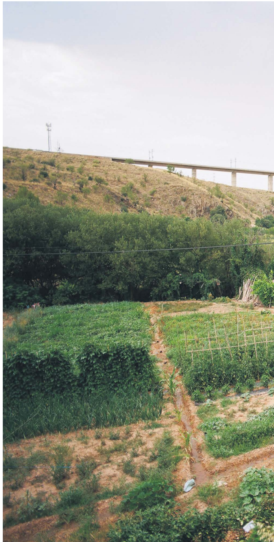
Viaducte a prop de Castejón de Armas (Saragossa).
