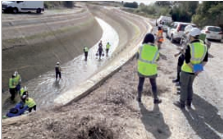
FOTO: Endesa/ Imatge dels treballs que s'estan fent a Balaguer
