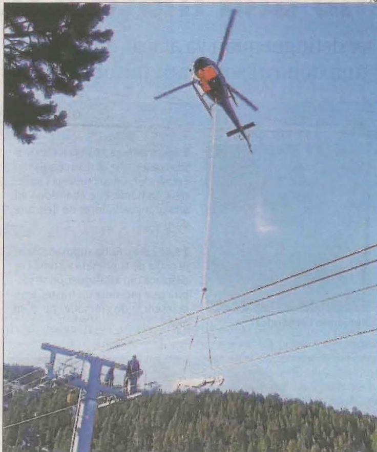
Un helicòpter desplaçant peces d'un remuntador a Port Ainé.
