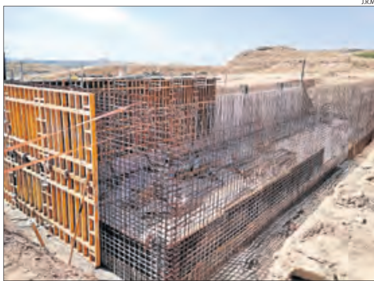
Les obres de la planta de selecció que s'executa a Montoliu.
