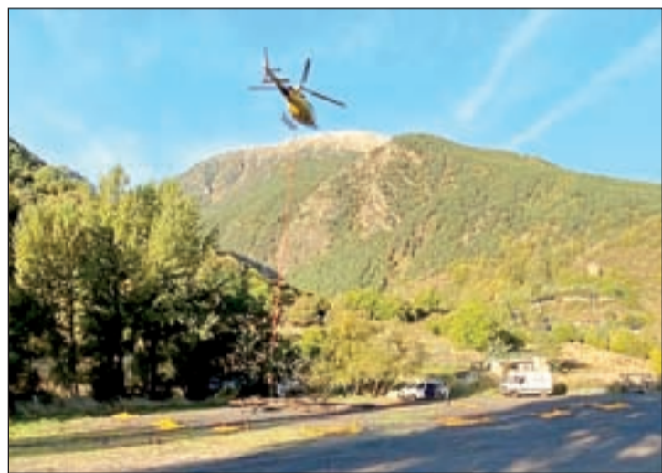
FOTO: Endesa/ Imatge dels treballs que s'han dut a terme
