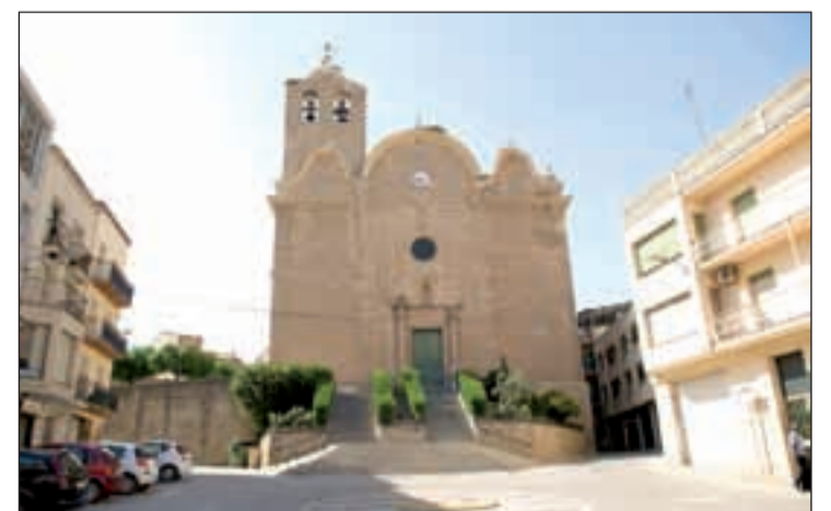
FOTO: Aj. Alcarràs/ El cost de les obres rondan els 8.000 euros
