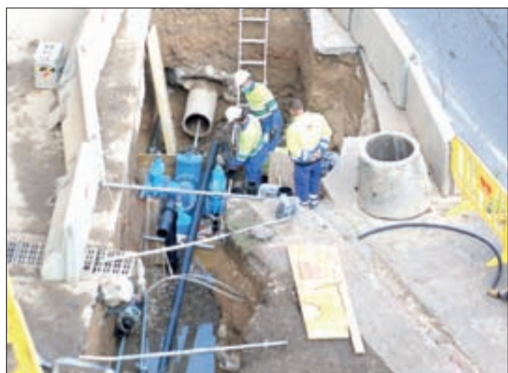
FOTO: T. Alcántara / Operaris reparen la fuga trobada al manteniment
