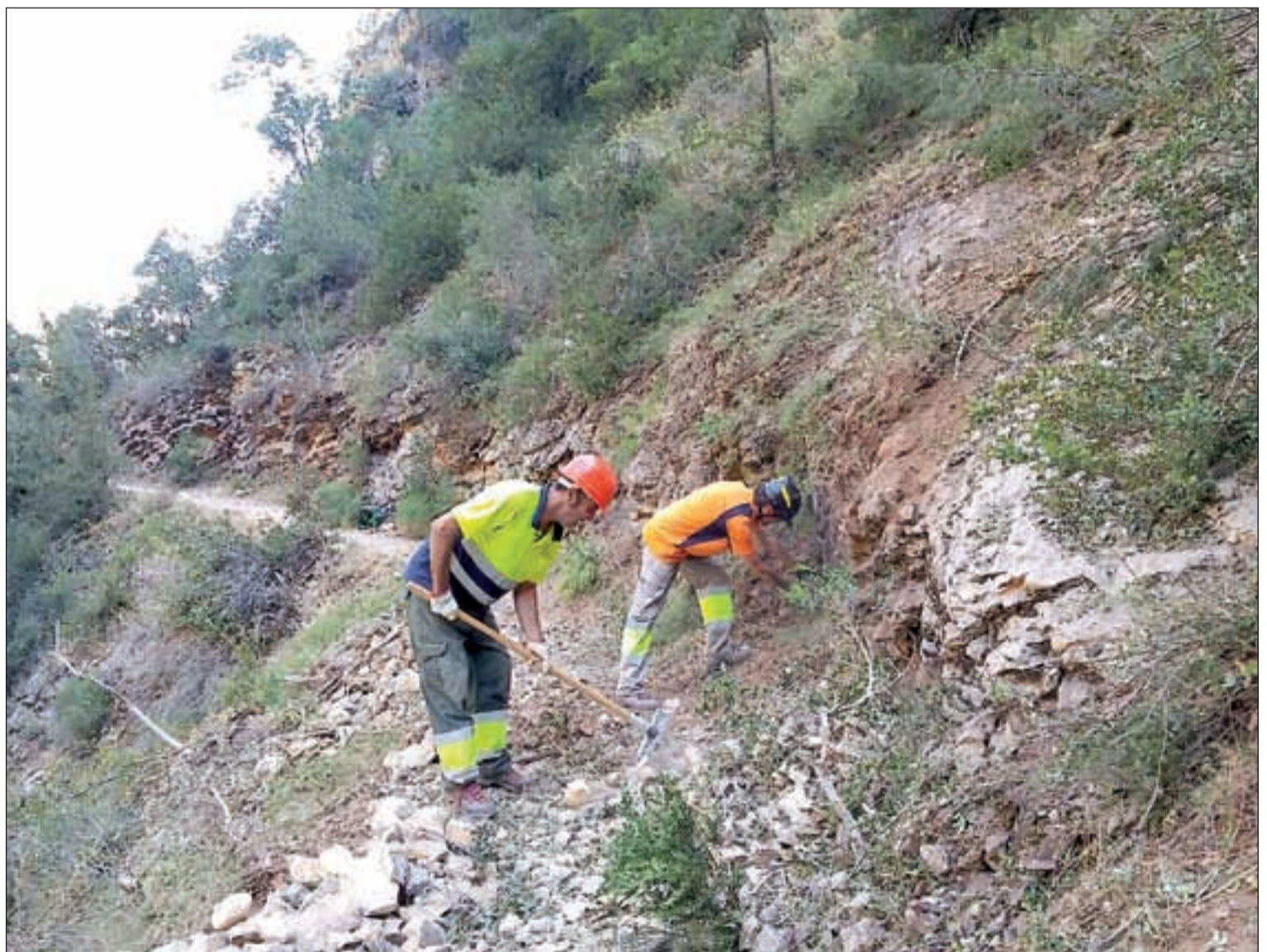
FOTO: Consell Comarcal del Pallars Jussà/ Imatge d'arxiu d'operaris treballant en la retirada de les roques caigudes el 17 de juliol de l'any 2019
