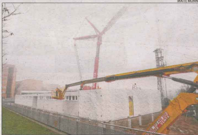
L'ampliació de l'Arnau amb un nou edifici pren forma.
