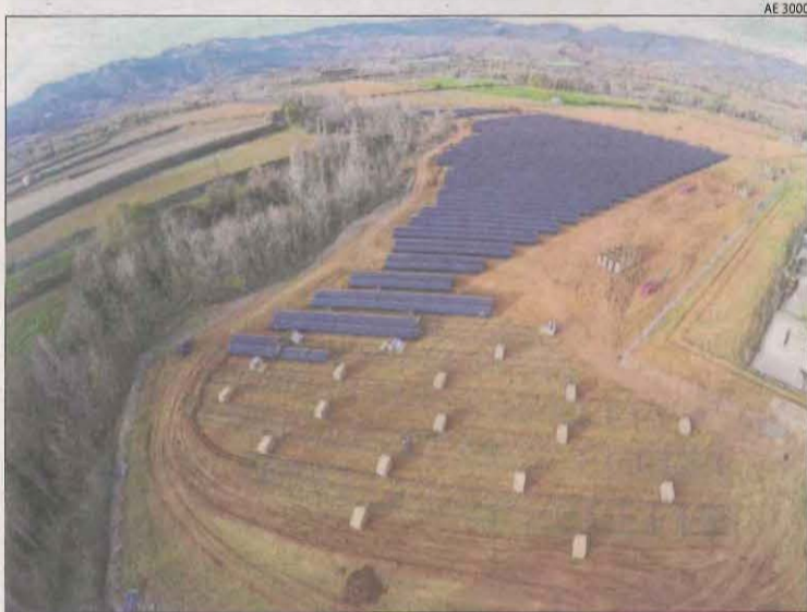
Imatge d'arxiu de la central d'energia solar a Talarn.
