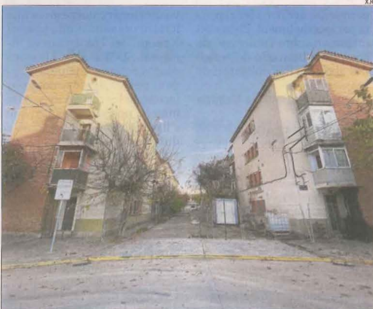
Imatge del grup d'habitatges Sant Isidori de Mollerussa.
