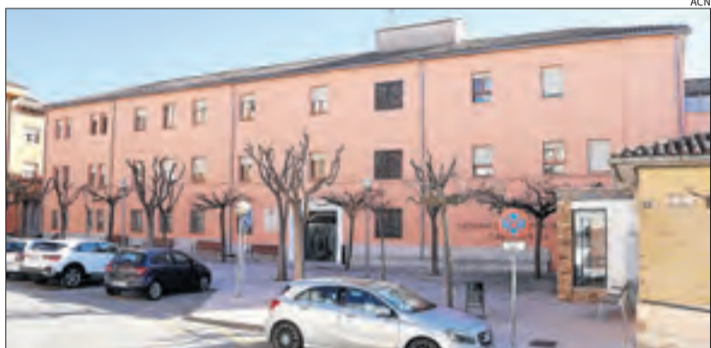
Imatge de la façana de la residència de Trepmp.
