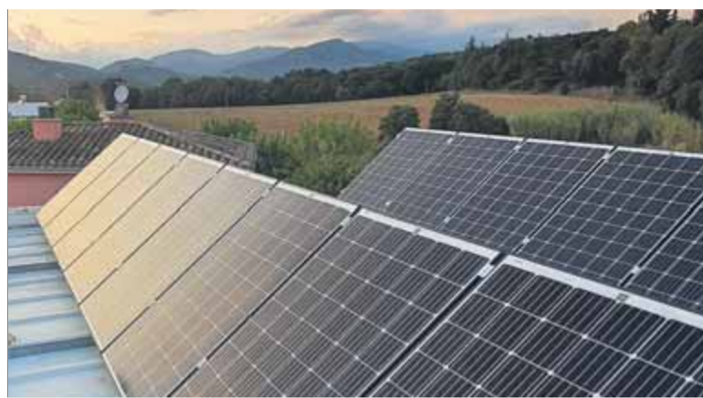
Plaques fotovoltaïques en un teulat d'un edifici ■ GEOTERMIA
