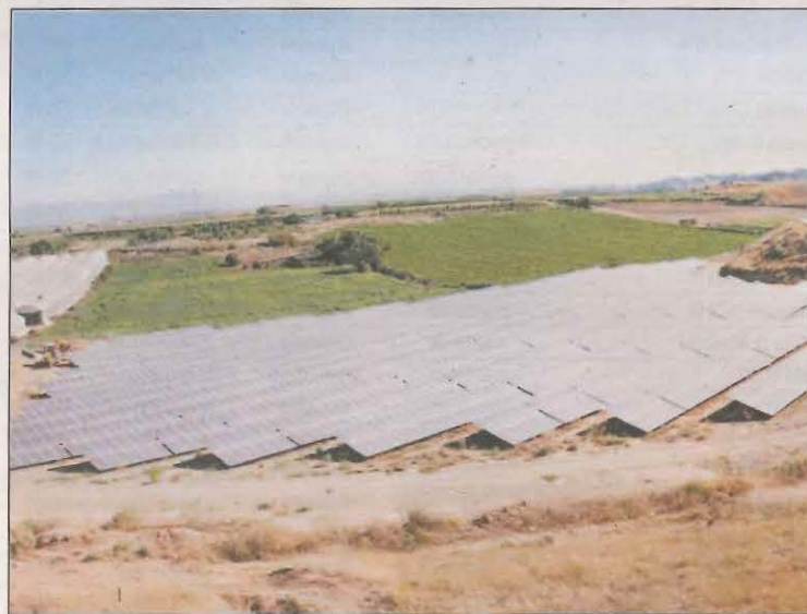
FOTO: J.P. / Imatge d'arxiu de plaques solars instal·lades a Almacelles
