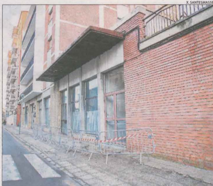
Es va instal·lar una tanca en un tram d'uns 15 metres.
